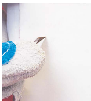
1. verflaag insnijden
